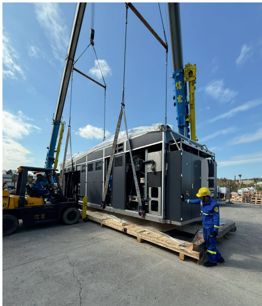
Das Edwards-System benötigte schwereres Gerät, um allein die Grundanlage mit 30 t bewegen zu können. (Bild: LPW)
