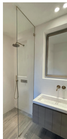
Fixation sol plafond avec méplats d'encadrement 5 mm, discrets
