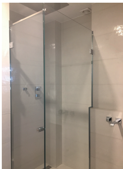
Verre latéral en appui sur un muret
