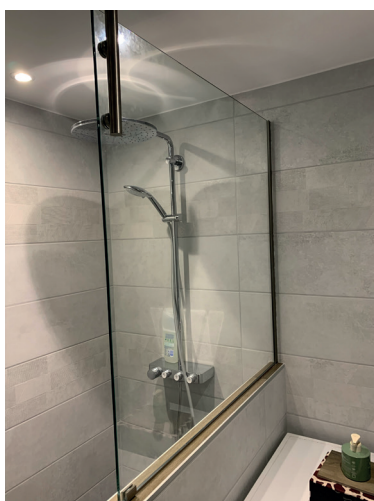
Cloison pare-baignoire sur muret avec raidisseur plafond. Décor Laiton brossé
