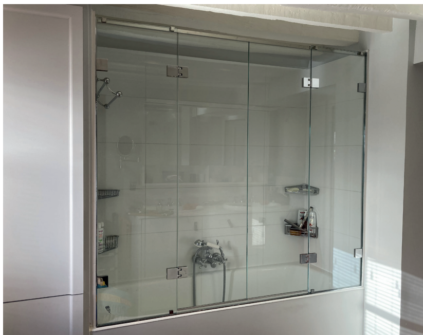
Façade à double porte montée en pare baignoire
