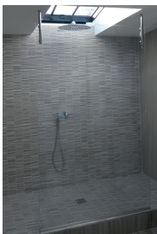
Cloison grande hauteur avec doubles raidisseurs plafond
