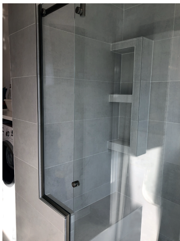
Fixe de façade en appui partiel sur un muret
