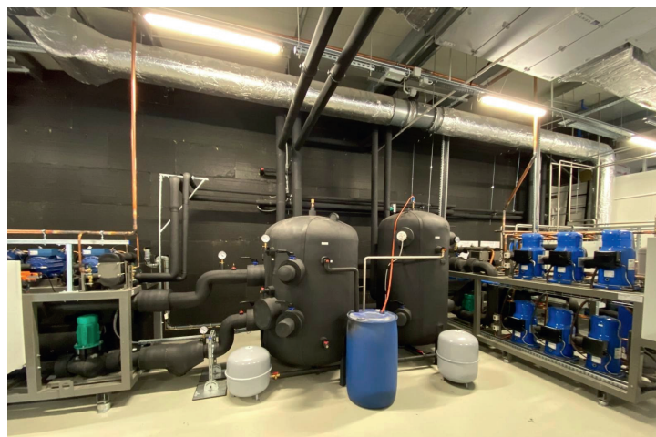
Maszynownia ZM Szubryt. Po lewej widoczny zespół sprężarkowy POWERCOOL CW 90, po prawej chiller SW440
