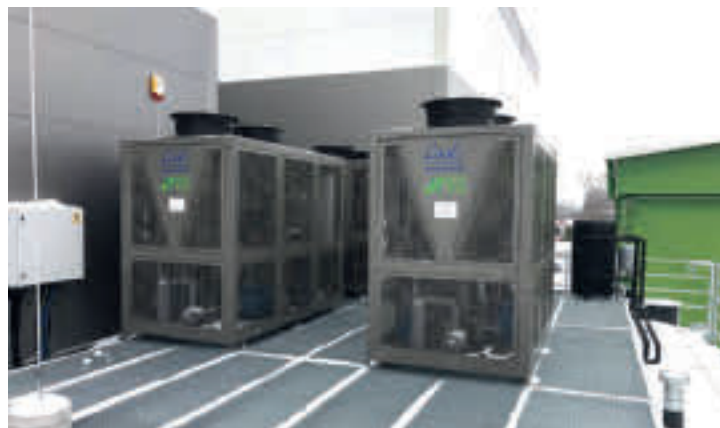
Agregaty kaskadowe POLARCOOL w Edpolu. W głębi za agregatami widoczny chiller VCGN.
